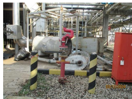
รูปที่ 3-60 Water Hydrant บริเวณกระบวนการผลิต
