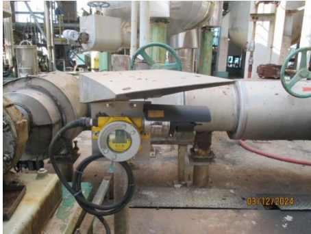
รูปที่ 3-46 Gas Detector บริเวณกระบวนการผลิต
