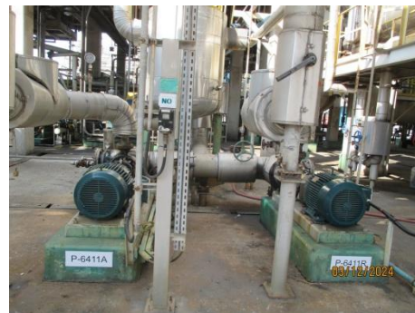
รูปที่ 3-9 Double Mechanical Seal Pump
