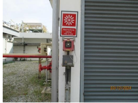
รูปที่ 3-49 Fire Alarm Manual System
