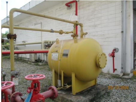
รูปที่ 3-52 Bladder Foam Tank
