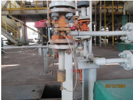
รูปที่ 3-10 Line Drain ที่มีฝาปิด
