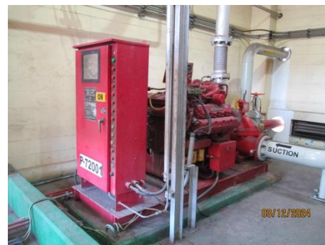
รูปที่ 3-51 เครื่องสูบน้ำดับเพลิง
