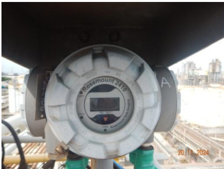
รูปที่ 3-63 Level Indicator บริเวณถังกักเก็บ
