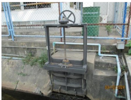
รูปที่ 3-71 Sluice Gate
