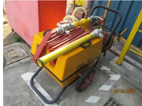
รูปที่ 3-53 Mobile Foam Tank
