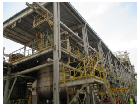
รูปที่ 3-7 ท่อจาก Reactor ไปที่หอเผา
