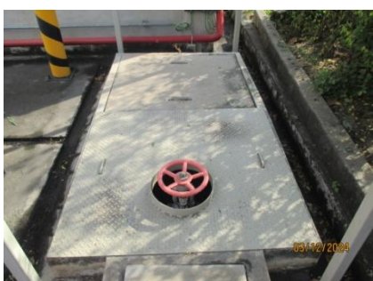
รูปที่ 3-37 บ่อ (Sump) รวบรวมสารเคมีที่อาจหกรั่วไหล
