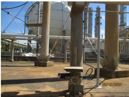
รูปที่ 3-65 Gas Detector บริเวณถังกักเก็บ
