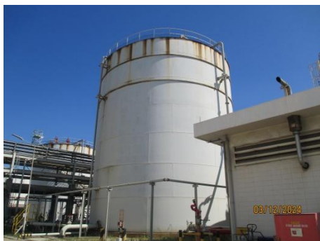
รูปที่ 3-50 ถังเก็บสารองน้ำดับเพลิง
