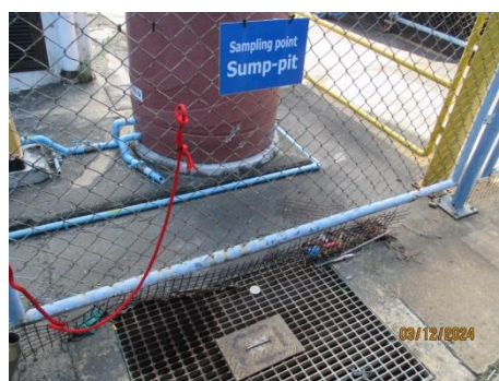
รูปที่ 3-31 บ่อรองรับ (Sump Pit)
