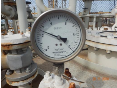
รูปที่ 3-61 Pressure Indicator บริเวณถังกักเก็บ
