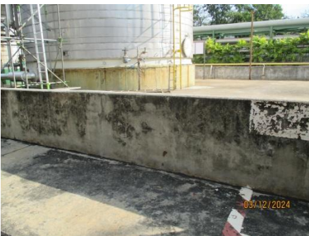
รูปที่ 3-59 กำแพงกั้นบริเวณถังสารเคมี
